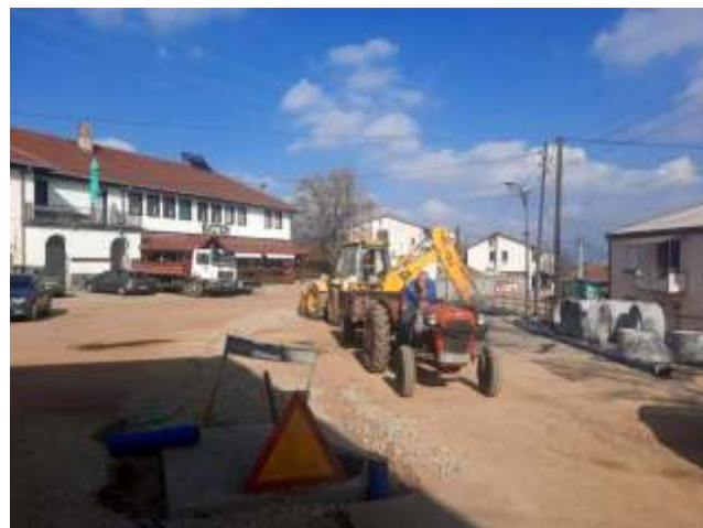
Промена на водоводни цевки во с. Владимирово
